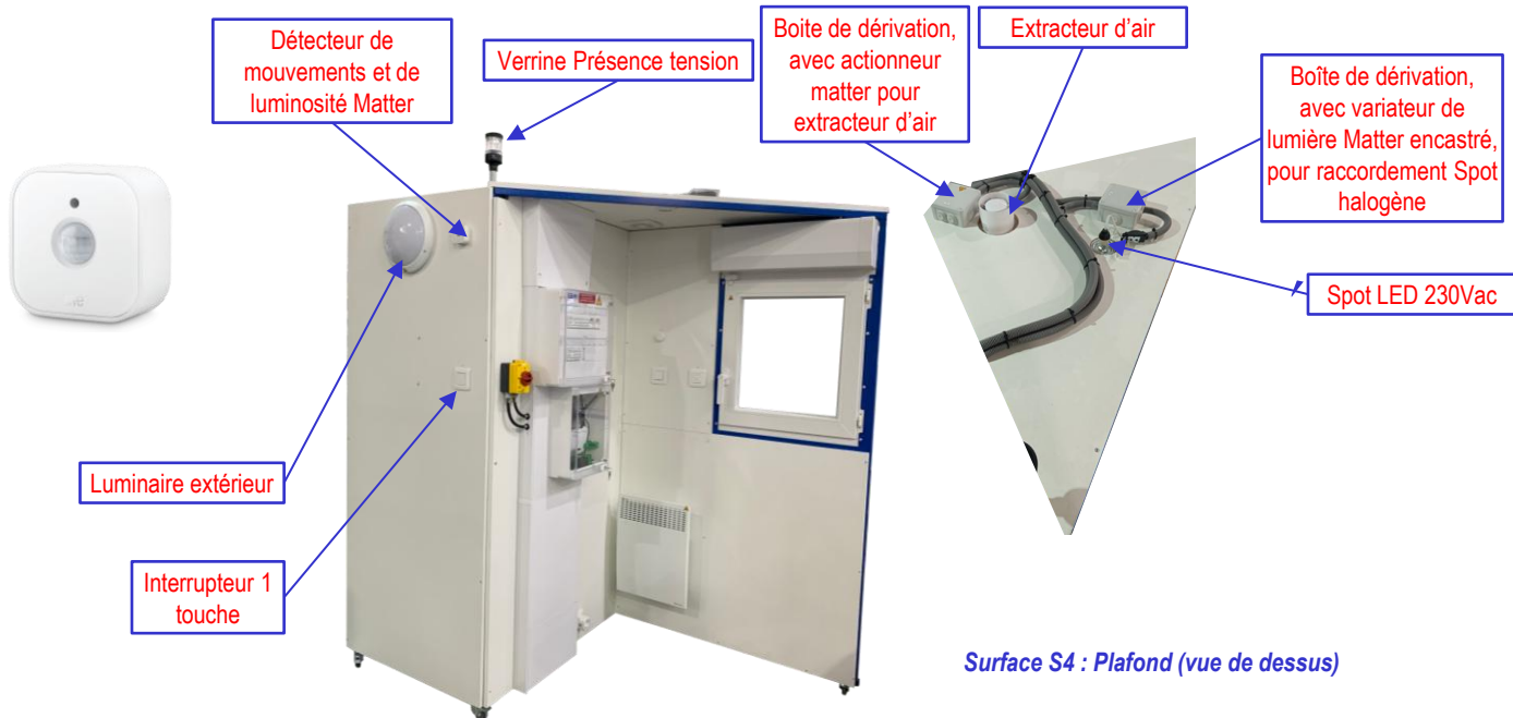
Surface S3 : Mur extérieur (vue de face)
