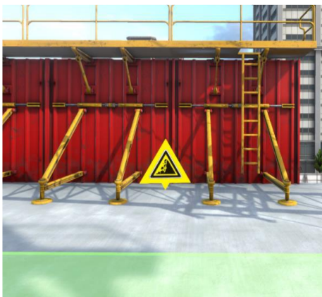
Poste de travail « Coffrage de voile banché »
