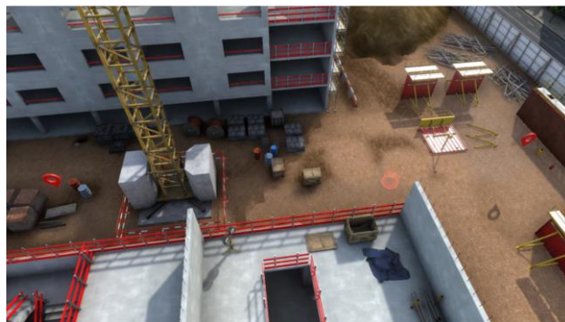
Poste de travail « Découpe de panneaux de coffrage »
