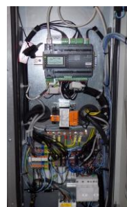
Coffret électrique avec automate M172
