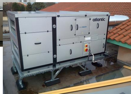
Exemple de CTA Compact en situation réelle (modèle précédent)
