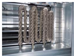
Batterie préchauffage
