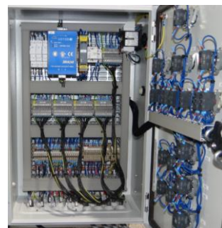
Coffret électrique avec borniers de raccordement classiques et enfichables
