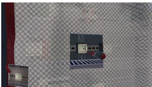
Illustration du remplacement du contacteur
