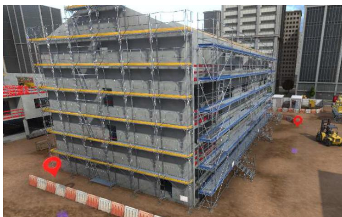
Zone des deux échafaudages
