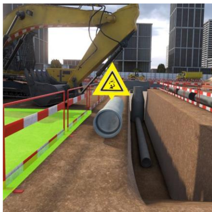
Poste de travail « Pose de canalisation en fond de tranchée »
