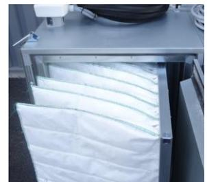
Le caisson préfiltre est équipé d'un filtre de type G4, fixé sur un cadre coulissant hors du caisson
