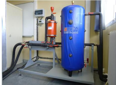
Ballon tampon d'une capacité de 200 litres
