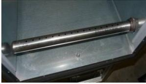
Rampe d'injection de vapeur en entrée de caisson. Le reste du caisson est vide afin de permettre la diffusion de la vapeur et éviter les risques de condensation sur les parois.
