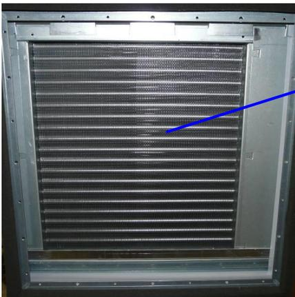
Echangeur air-eau (composé de tubes sur lesquels sont soudés des ailettes)
