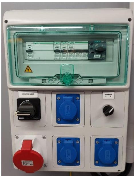
Coffret électrique de box de soudure
