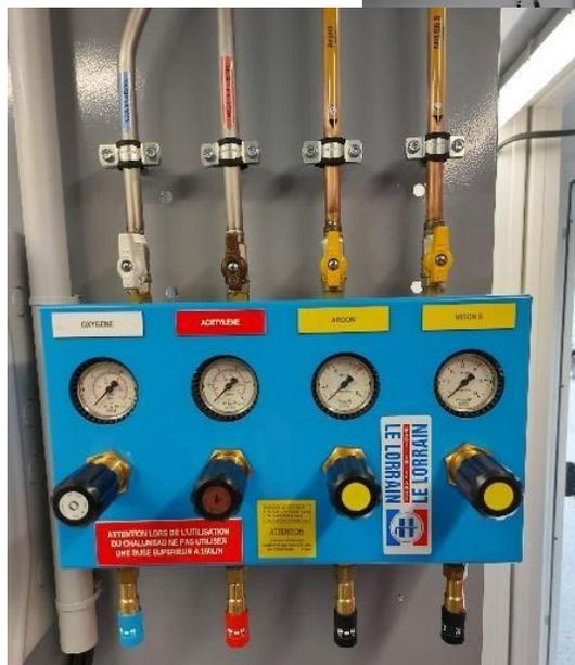
Platine Détendeurs de gaz (Argon, Mison, Oxygène, Acétylène)
