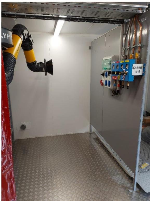
Box de soudure prêt à recevoir un poste à souder
