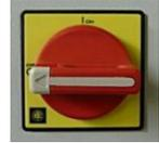
1. Avant toute mise en route du système, il faut que **l'interrupteur sectionneur** soit **ouvert** :
