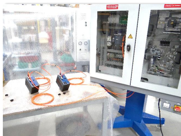
Mise en œuvre d'un mini-réseau fibre optique urbain (BT40 avec option FF30)
