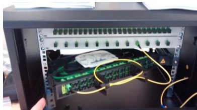
Vue de la baie de brassage SRO incluse dans FF12 (Déploiement horizontal)
