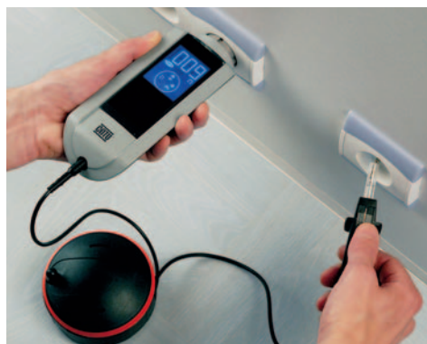
Contrôle de continuité entre prises
