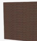
Mur de briques
