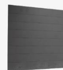
Mur de parpaings
