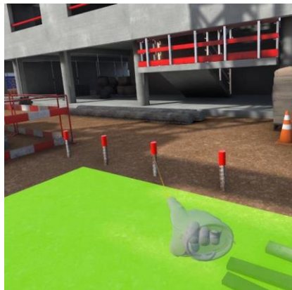
Poste de travail « Réception de charges sur zone de stockage », armatures d'attente sécurisées par embouts de protection
