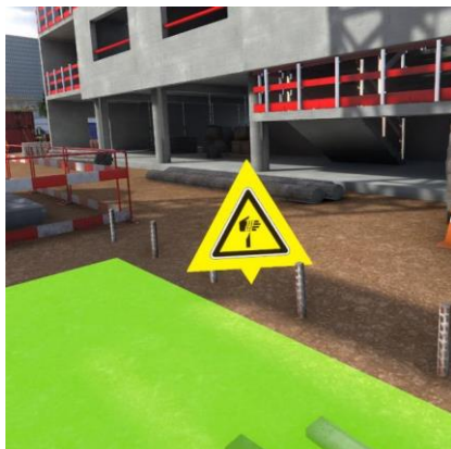
Poste de travail « Réception de charges sur zone de stockage », armatures d'attente non sécurisées
