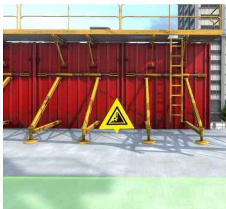
Poste de travail « Coffrage de voile banché »
