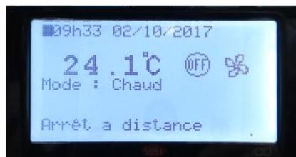
La centrale de traitement d'air entrera alors en phase d'arrêt, avec retour à 0 des commandes batteries, humidificateur et ventilateur reprise, ainsi qu'une post-ventilation de 120s sur le ventilateur soufflage.
